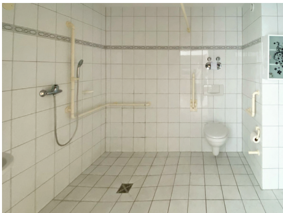
Bad mit Dusche
